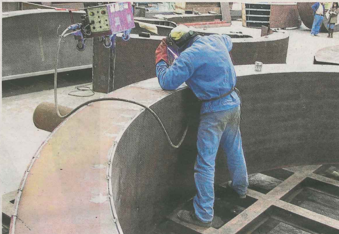
Un empleado de una empresa vizcaína realiza trabajos de soldadura. Foto: DEIA
